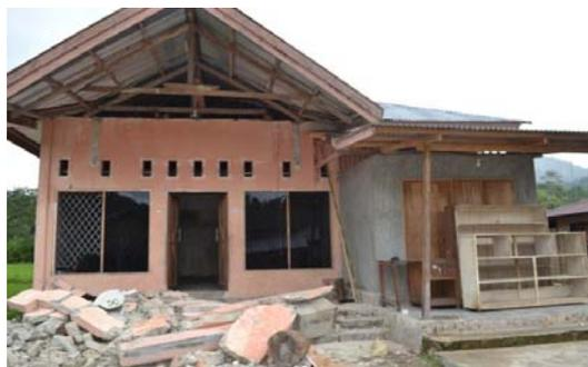
Gambar 6. Rumah dari pasangan bata yang ambruk karena tulangan tidak memenuhi persyaratan dan kualitas beton yang buruk sesaat setelah gempa
