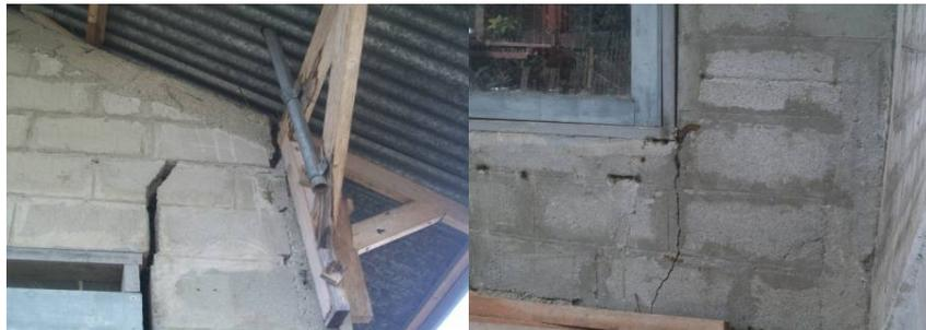
Gambar 5. Bagian struktur bangunan sederhana yang rusak karena metode pelaksanaan pekerjaan yang buruk dan tidak mengacu Standar Nasional Indonesia (SNI)
